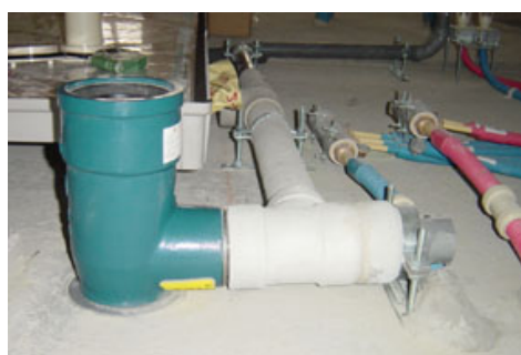
写真8 KSTS スラブ上面接合 施工例
