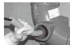
KSGを用いた洗浄風景
