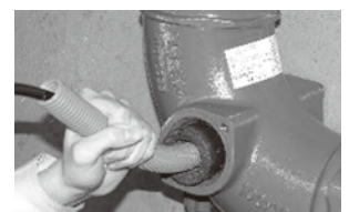
KSGを用いた洗浄風景
