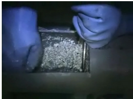
排水横主管での洗浄状況を動画でご覧になれます。
