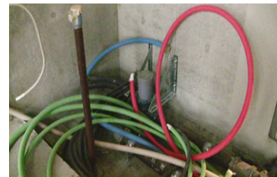
継手支持用ブラケット施工状況 (追100625)
