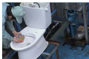
CPジョイント内部での ②スポンジ通過状況
