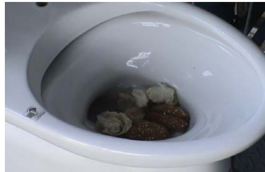
大便器の排水状況
