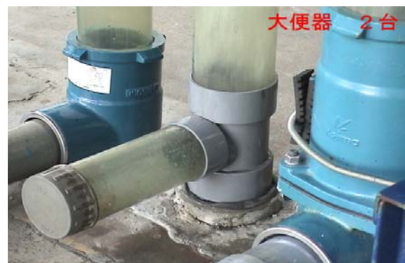
DT横枝管への流入状況
