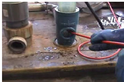
横枝管の高圧洗浄
