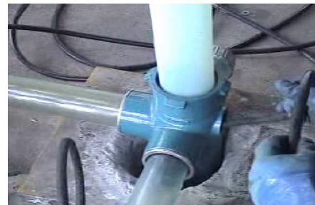
立て管の高圧洗浄
