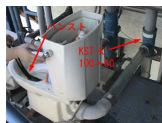
KST-K100×80内部のパンスト通過状況
