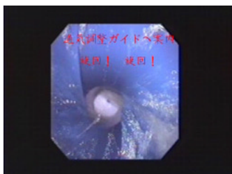
HPジョイント内部の流下状況
