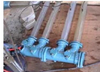
排水ヘッダーの最下流より 洗浄ノズルを挿入
