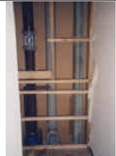
排水立て管の更新、2 分割した排水立て管を掃除口継手で接続した例
