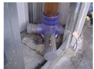
写真-2 5階 樹脂製継手
