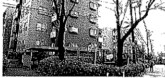
2月2日着工、3月31日竣工台所系統排水管の更新工事が行われている「西所沢榎ニュータウン第13」
